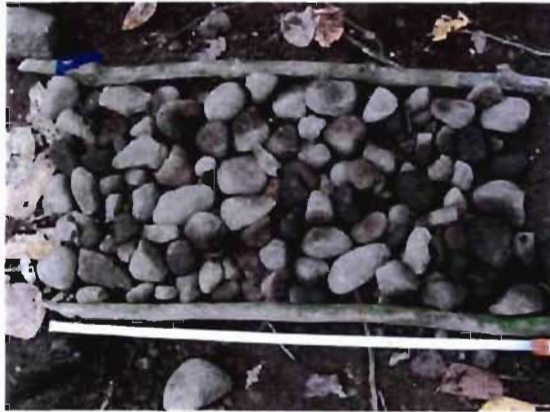
Moellons ajoutés au remblai.
